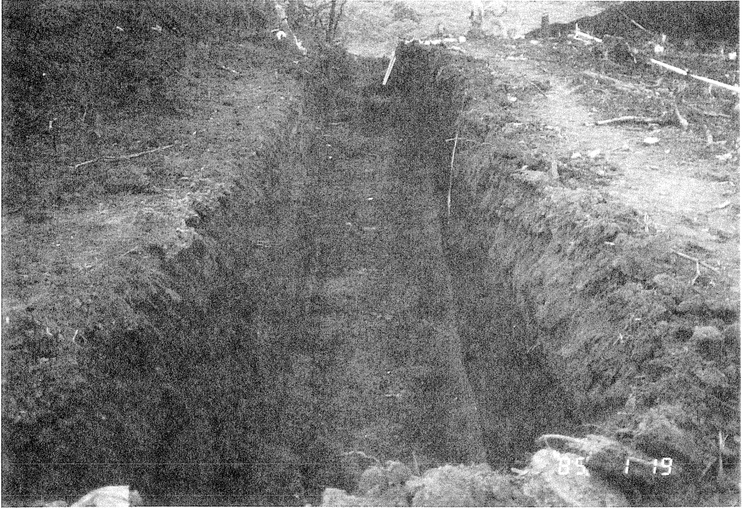
図版6 Cトレンチ全景（東方より）
