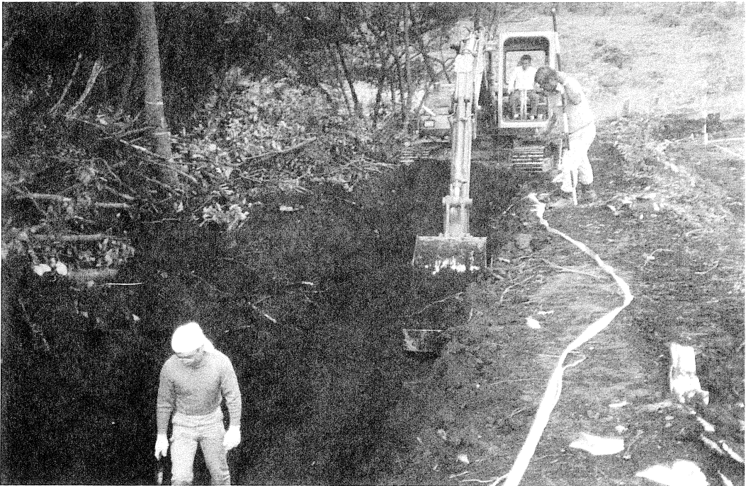
図版7 掘さく中のCトレンチ
