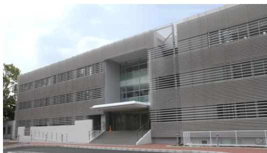
南面外壁日射調整ルーバー (本部棟)
