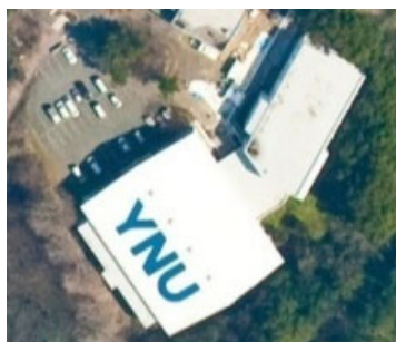
屋根遮熱塗装 (体育館)
