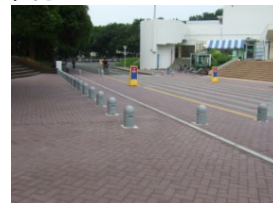
歩行者優先の段差のない横断歩道
