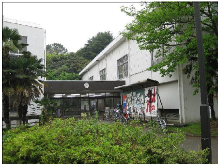
エントランス外観 before
