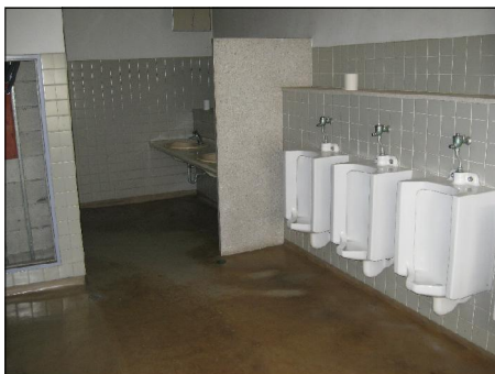
武道場 1Fトイレ before
