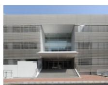
本部棟の南面外壁に設置した日射調整ルーバー
