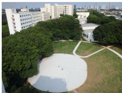
防災拠点機能を強化した中央広場
